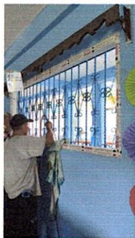
Foto 1: Sustitución de ventanas de aluminio por ventana de pvc.
