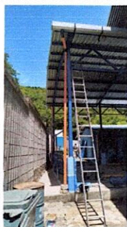
Foto 5: Reemplazo de bajada pluvial, con tubo pvc.
