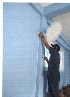
Foto 6: Instalación de tomacorriente: con canaleta, fijado con tarugos y tornillos.
