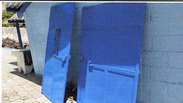
Foto 3: Mantenimiento de puerta: Lijado, pulido y pintura.
