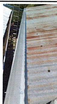
Foto 4: Reemplazo de canal de agua pluvial.
